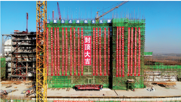
▲ 2019 年 12 月 31 日，中国环保滦水公司主厂房顺利封顶。
