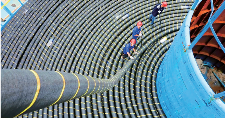
▲ 阳江南鹏岛海上风电项目现场，员工正在紧锣密鼓地进行海上电缆的装船作业，为下一步海缆敷设、完成海上升压站与陆上集控中心的连接做好充分的准备工作。
