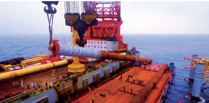
▲ 2019 年 5 月 22 日，广东阳江南鹏岛海上风电项目完成 1 个风机组的 4 根钢管桩沉桩作业；8 月 13 日，升压站基础建造完成；8 月 14 日，海缆成功登录。
